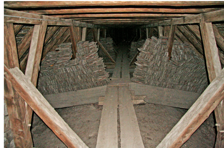
Une des poutres en béton et le poids des tuiles en réserve
