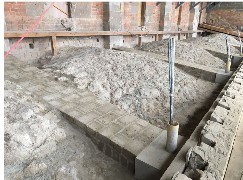
Restitution du dessus de façade, des arcs et des voûtes
