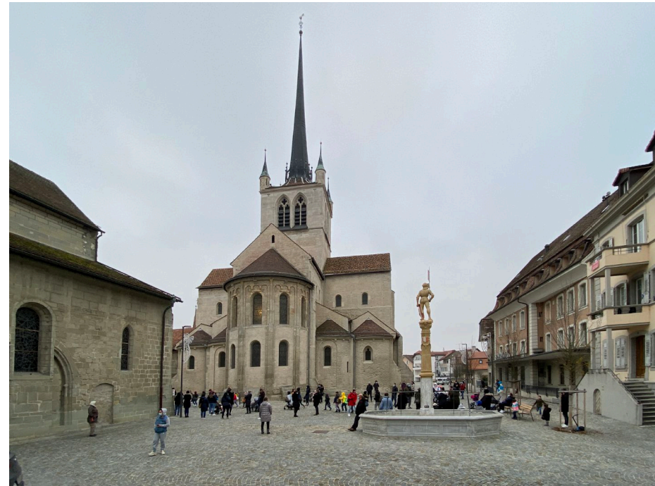
L'abbatiale avec la fontaine du temple et le nouvel aménagement de la place.
