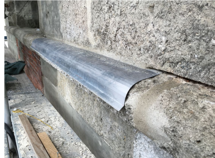
Protection d'un profil en pierre par une ferblanterie
