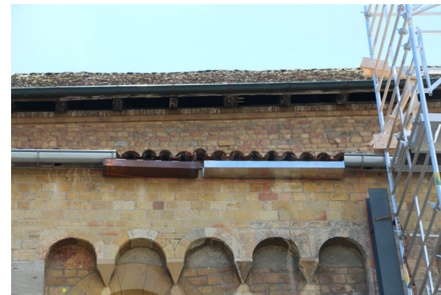
Plan et essai avec variantes de section et de matériau de chenaux (bureau Kolecek Guido Faccani)
