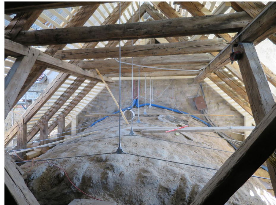
Système de tirants pour la charpente
