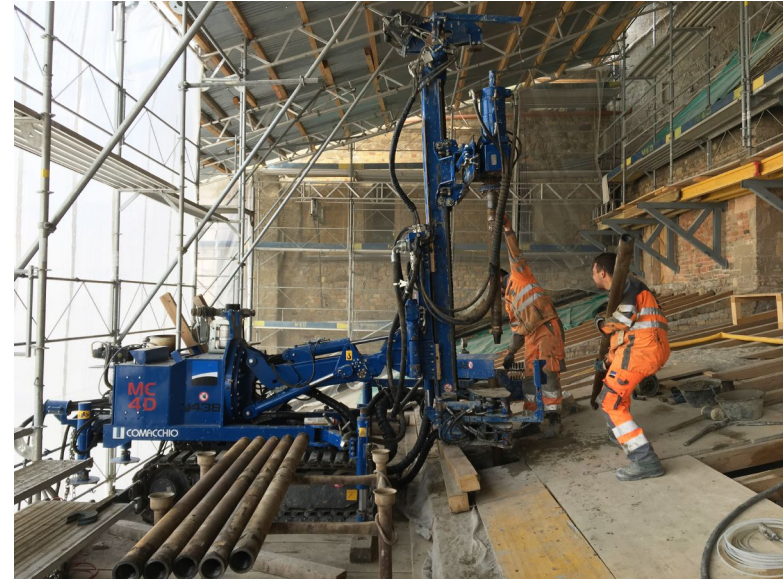
Machine de forage sur le bas-côté nord
