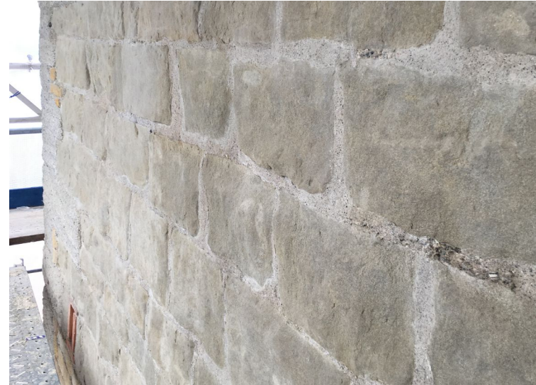
État des faces en molasse après restauration
