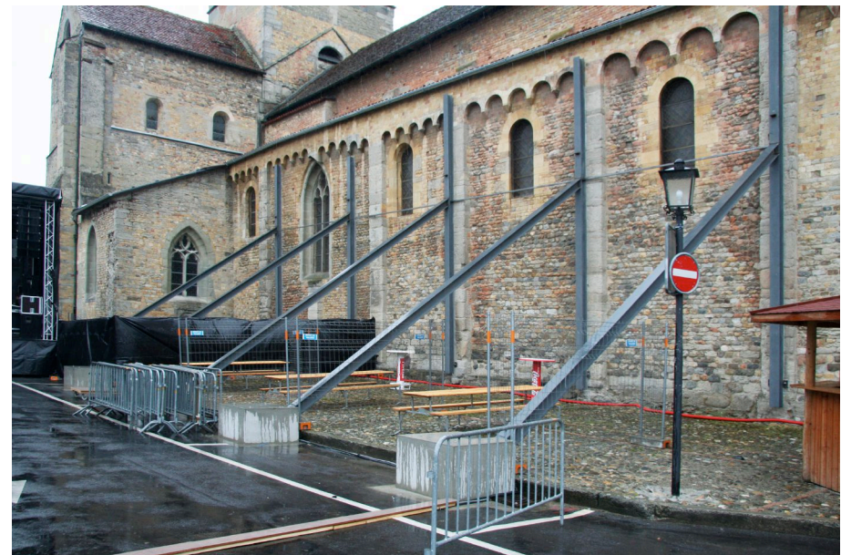
Étayage de sécurisation, bas-côté nord
