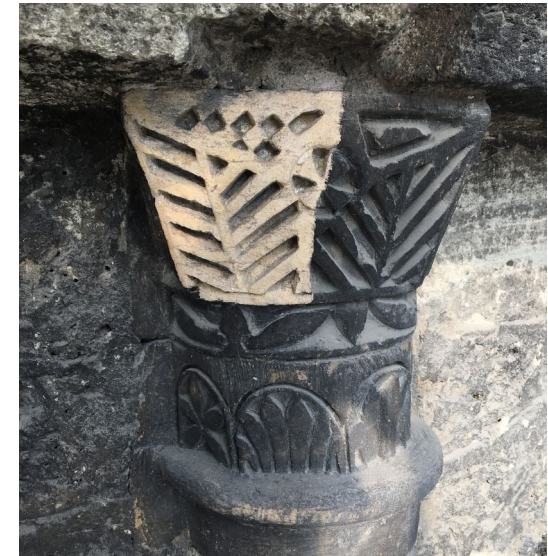
Effet de nettoyage au laser, chapiteau du chœur
