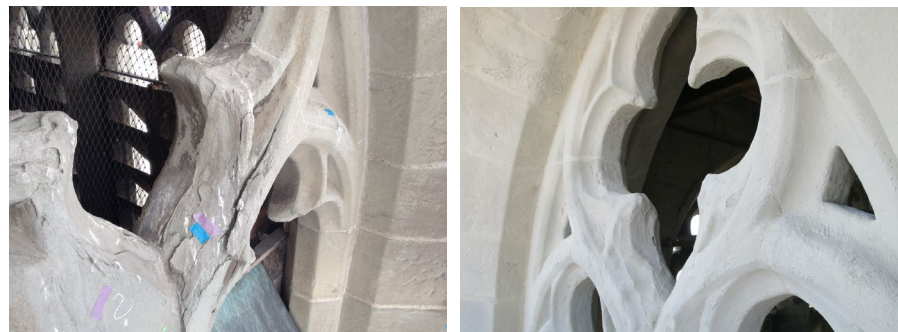
Remplage de la tour côté est : état avant et après restauration
