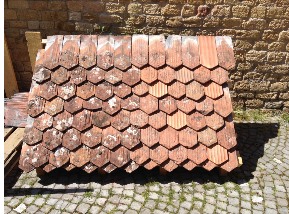
Les tuiles historiques traitées et les tuiles de remplacement
