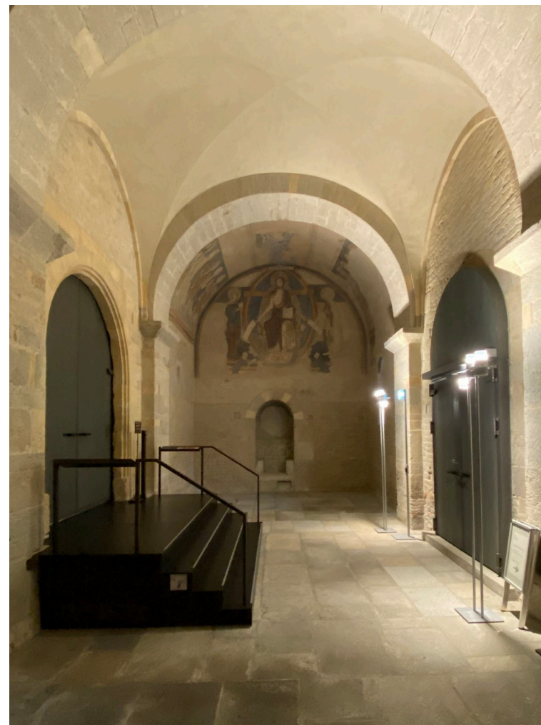
Le narthex, au fond la porte murée et l'oculus installé par la suite, au premier plan le grand bloc de l'escalier et les nouvelles portes.
