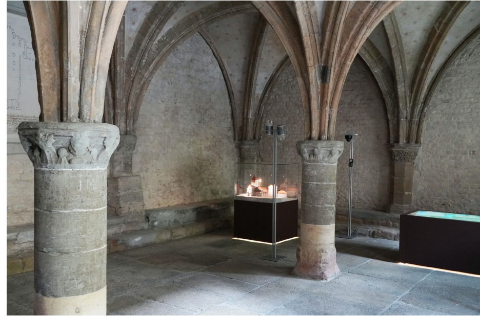
La salle capitulaire restaurée, épargnée d'installations muséographiques trop invasives
