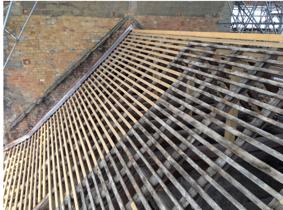
Lattage du 18 ème siècle sur la toiture du bas-côté sud
