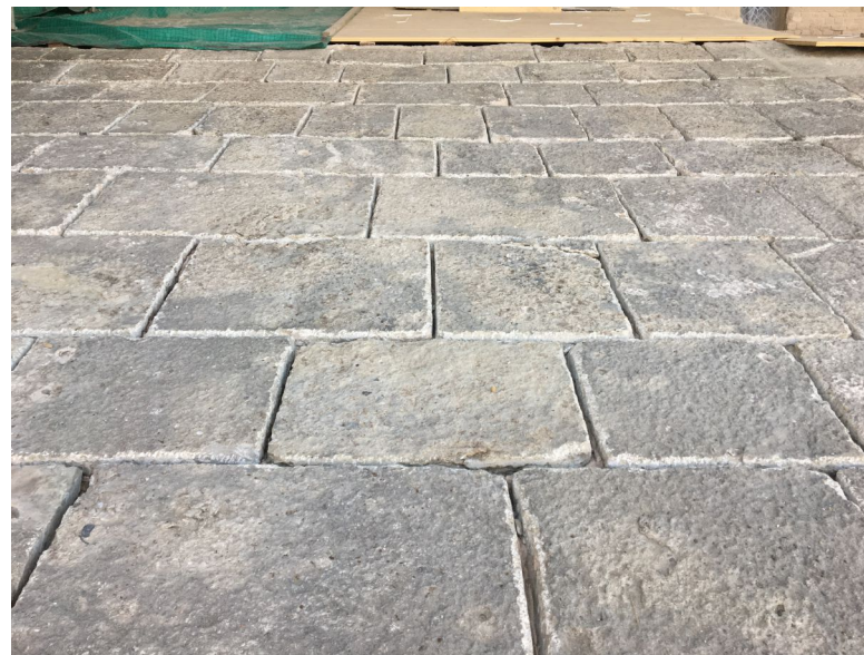
Toiture sur la chapelle d'Estavayer, après repose des dalles, avant jointoyage
