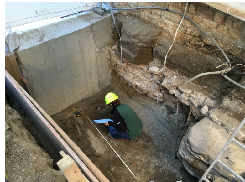
Fouilles archéologiques avant coulage du massif de béton de stabilisation
