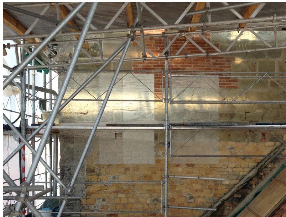
Une des séries d'échantillons de glacis en plusieurs épaisseurs
