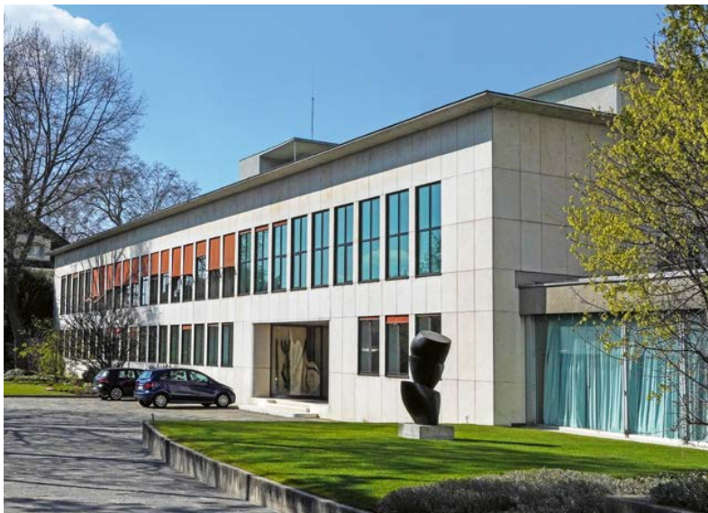
Otto Rudolf Salvisberg: Direktions- und Verwaltungsgebäude, 1934–1936. Die repräsentative Architekturikone soll restauriert und weiterhin genutzt werden.
