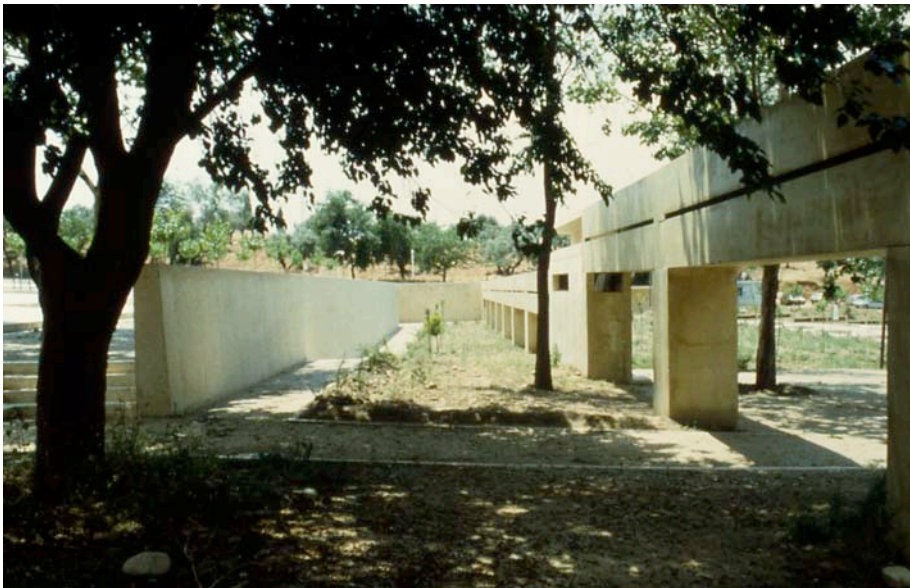
Illustration 2: Photo des installations d'entrée et de parking à l'Alhambra de Grenade.
