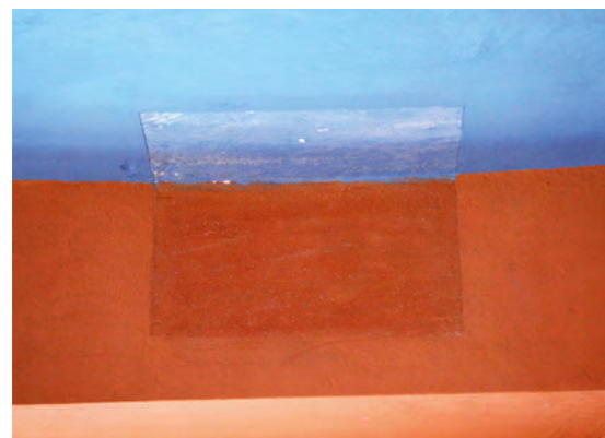
Abb. 10: Dokumentation der Sondierungen mit der originalen Färbelung (Photo B. Furrer).
